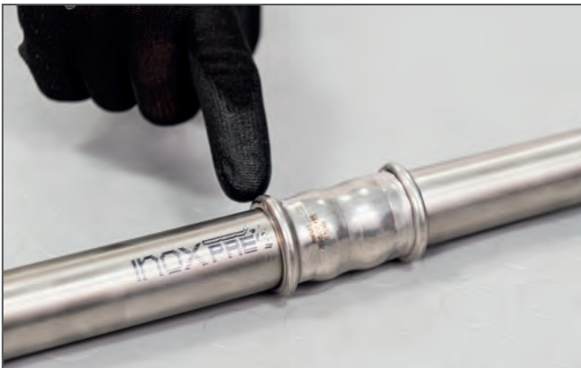
Controllo della pressatura / Checking the press connection
