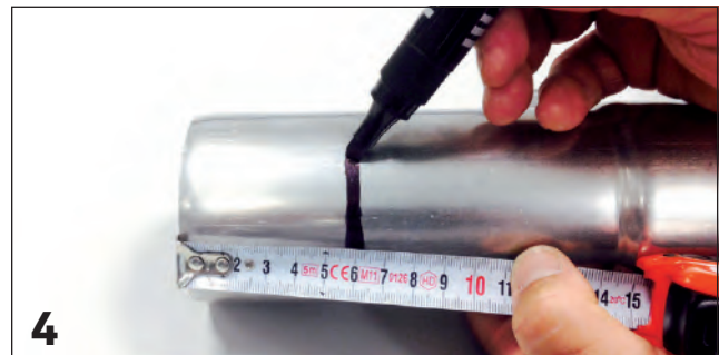
4 Marcatura quota d'innesto / Marking the insertion's depth
