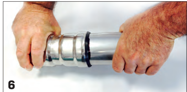
6 Inserimento tubo nel raccordo / Inserting of the pipe into the fitting
