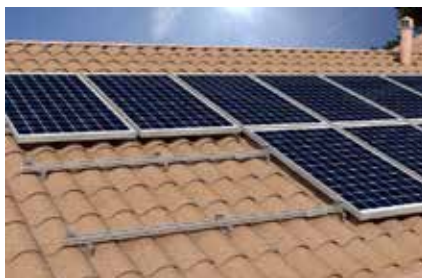
Tetto a falda con manto di copertura in tegole
